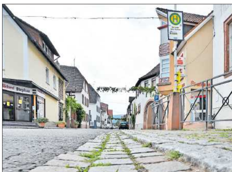
Soll barrierefrei ausgebaut werden: die Bushaltestelle am Alten Schulhaus in Kirrweiler. FOTO: MEHN
